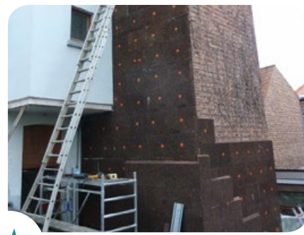
Isolation extérieure, isolation intérieure : plusieurs solutions sont envisageables. Les journées Écobâtisseurs vous permettront d'en savoir plus...
